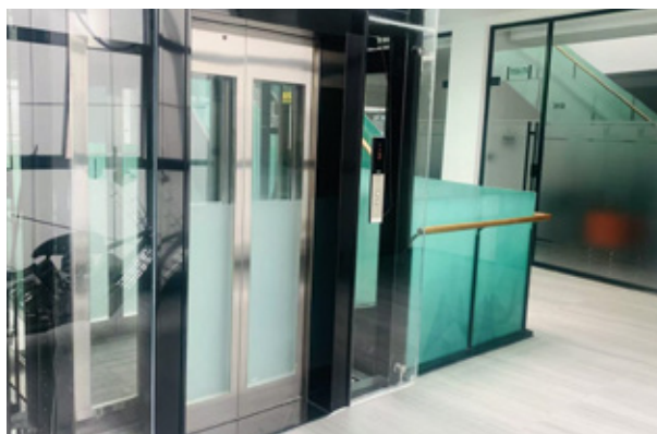
垂直电梯可直达二楼和三楼办公区
